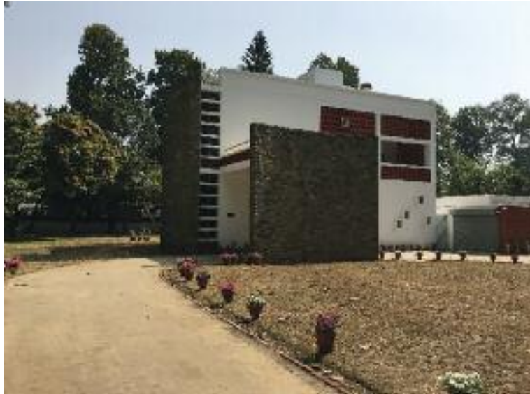
Chandigarh, maison de Pierre Jeanneret, extérieurs, après restauration Photo Chandigarh Administration
