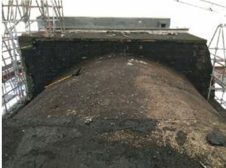
Voûte de l'atelier après dépose des étanchéités – Photo B. Gandini
