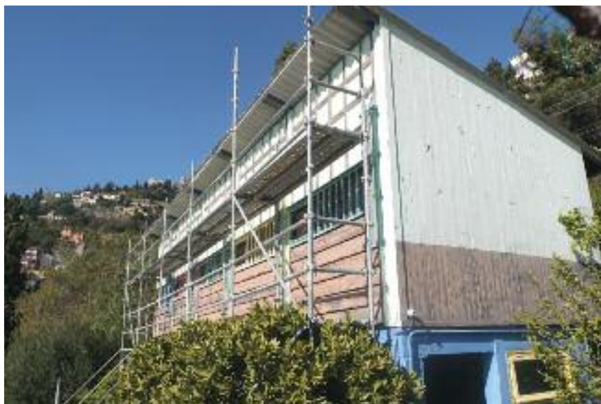
Chantier Unités de Camping – Photo B. Gandini
