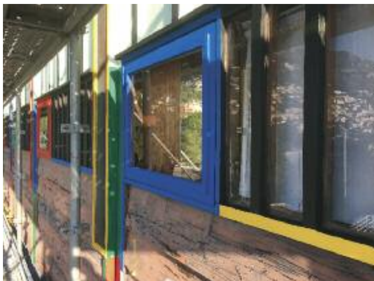
Détail chantier Unités de Camping Photo B. Gandini
